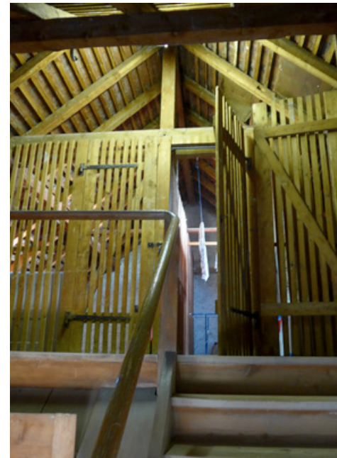
nicht ausgebauter Estrich, Haustyp H erste Etappe
