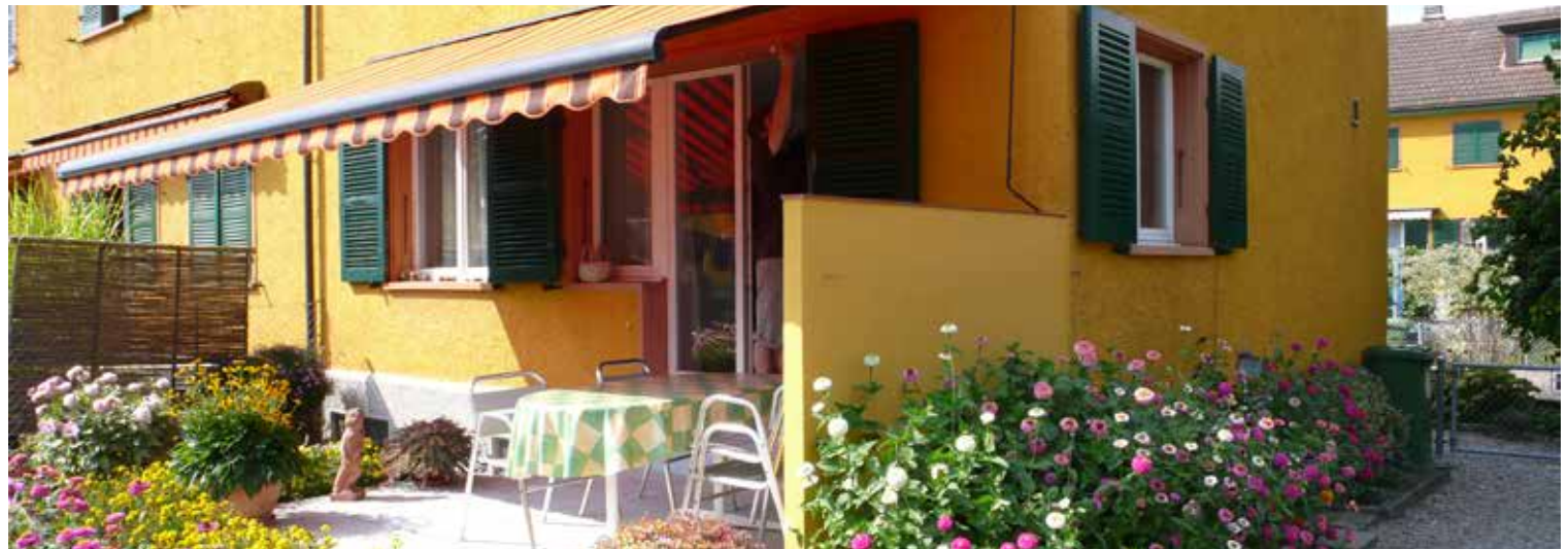
2. Etappe: Gartenzugang Mövenweg 16, Gebäudetyp I4, ursprüngliche Terrasse mit Mauer als Sichtschutz
