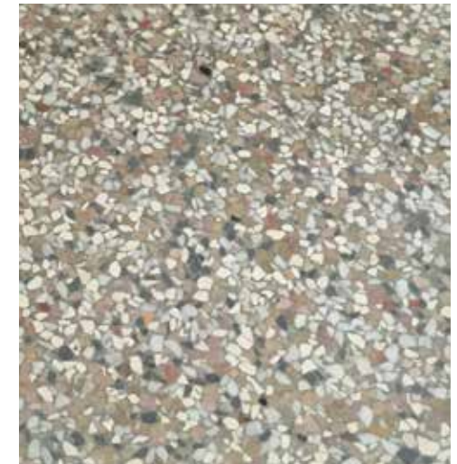
originaler Terrazzo aufgearbeitet und wieder sichtbar
