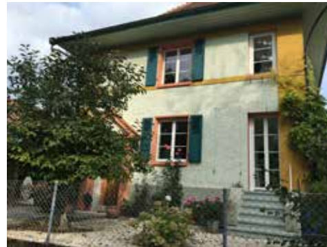
bestehender Ausgang Reckweg 7
