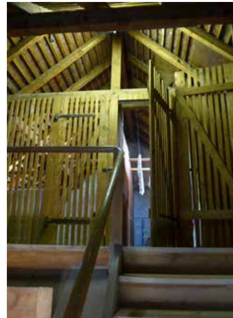
nicht ausgebauter Estrich Hofmattenstrasse 8
