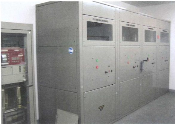
16kV Schaltanlage
