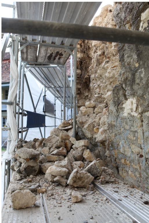
Einsturz und Schiefstellung der Stadtmauer West mit Sicherung
