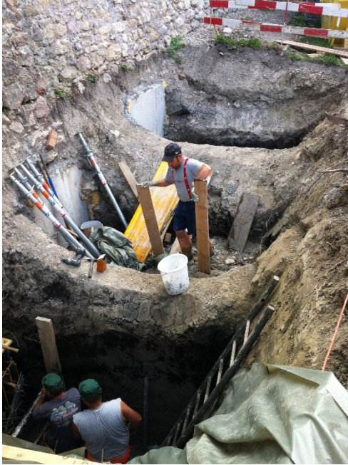
Riegel mit Pfählung Stadtmauer West
