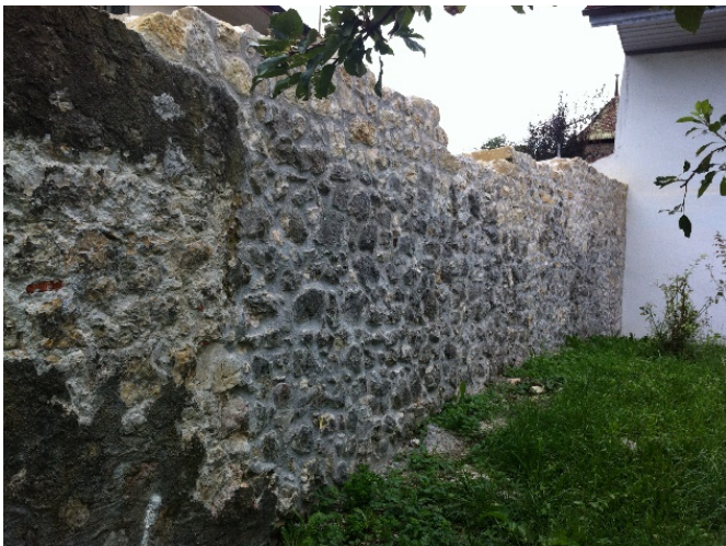
Sanierte fertiggestellte Stadtmauer Ost
