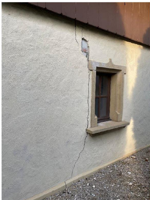
Abb5: Riss Südfassade
