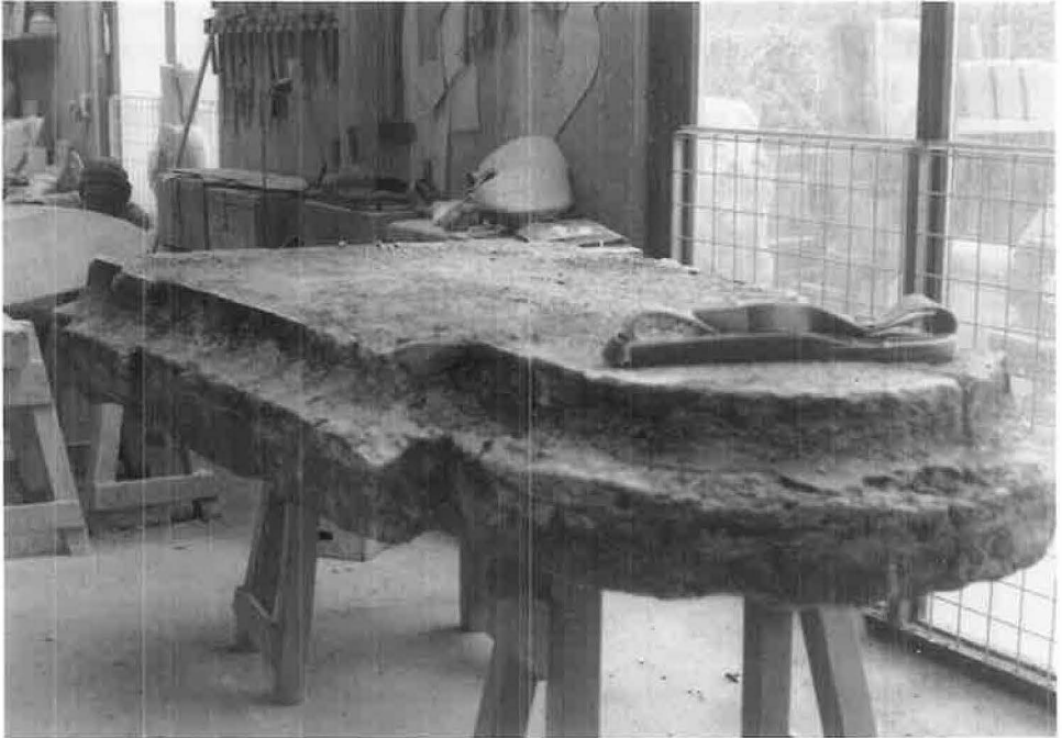
Zur Restauration des Stadthausbrunnens 1989/90: Die durch Witterungseinflüsse und Schadstoffimmissionen beschädigte Grundplatte (Hohlkehle) musste in den äusseren Teilen mit Vierungsstücken aus neuem Solothurnerkalkstein ergänzt werden (Atelier Brogni).
