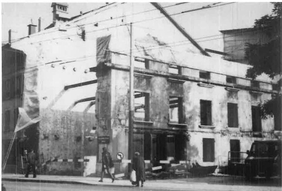
Die freistehende Südfassade (Rest der alten Stadtmauer) blieb bei der Restauration erhalten.
