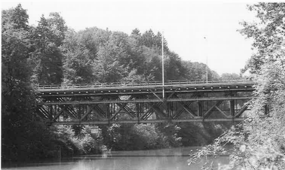
«Neue» Hagneckbrücke, erstellt in den Jahren 1902/3 nach Plänen der Nidauer Firma Probst, Chappuis & Wolf. Blick flussabwärts, Richtung Stauwehr. Aufnahme Sommer 1996. Auf Grund einer Intervention von Eduard Will im Jahre 1900 wurde bei der Projektierung und beim Bau der neuen Brücke das Trasse für das Bahngeleise der späteren Biel-Täuffelen-Ins Bahn (Erstellung 1914–1916) ausgespart. Die Kosten der neuen Brücke trug der Staat; die Mehrkosten von Fr. 7'000.– für das Trasse Bahngeleise mussten die Gemeinden übernehmen.
