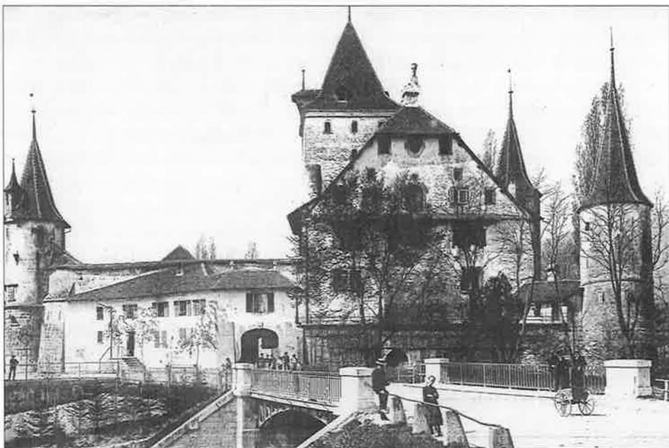
Abb. 35: Neue Schlossbrücke von 1877, eiserne Bogenfachwerkbrücke. Breite zwischen Eisengeländern 9 m. Davon entfallen 7,2 m auf die Fahrbahn und 1,8 m auf einen flussaufwärts angeordneten Fussweg (Trottoir). 7 Bogenfachwerkträger aus Schweisseisen im gegenseitigen Abstand von 1,4 m tragen die Zorseisen worauf das Schotterbett der Strasse ruhte. Die Lichtweite zwischen den Brücken-Widerlagern beträgt nur noch 12 Meter.
