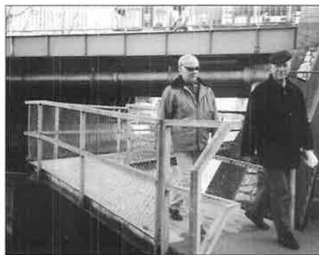
Abb. 62: Fussgängersteg unter der Industriebrücke, Beton, mit Rohrgeländer gegen die Zihl, erstellt beim Neubau der Brücke 1967. Ansicht vom See her Richtung Schloss. Im Vordergrund die 1979 verbreiterte Fussgängerrampe als Zugang vom Uferweg.
