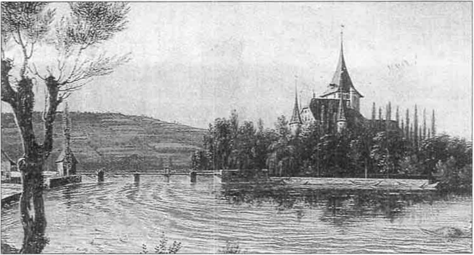
Abb. 13: Kopie Gouache über Bleistift, datiert 1843, von Andreas Keller (1796–1855). Das Radhaus besteht nicht mehr. An Stelle von bisher fünf Pfeilern noch deren vier, davon der zweite von Westen aus Holz. Aufziehvorrichtung zwischen zweitem und drittem Pfeiler, aufziehbarer Brückenteil zwischen drittem und viertem Pfeiler.
