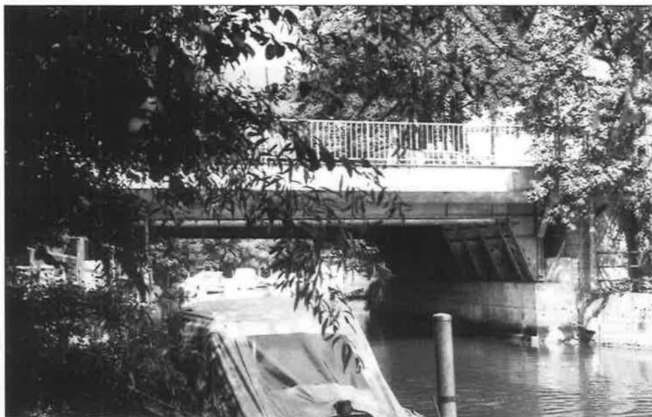
Abb. 40: Schlossbrücke von 1931 nach Verbreiterung von 1962, flussaufwärts. Am östlichen Widerlager (rechts) ist die Verbreiterung am Beton ablesbar.
