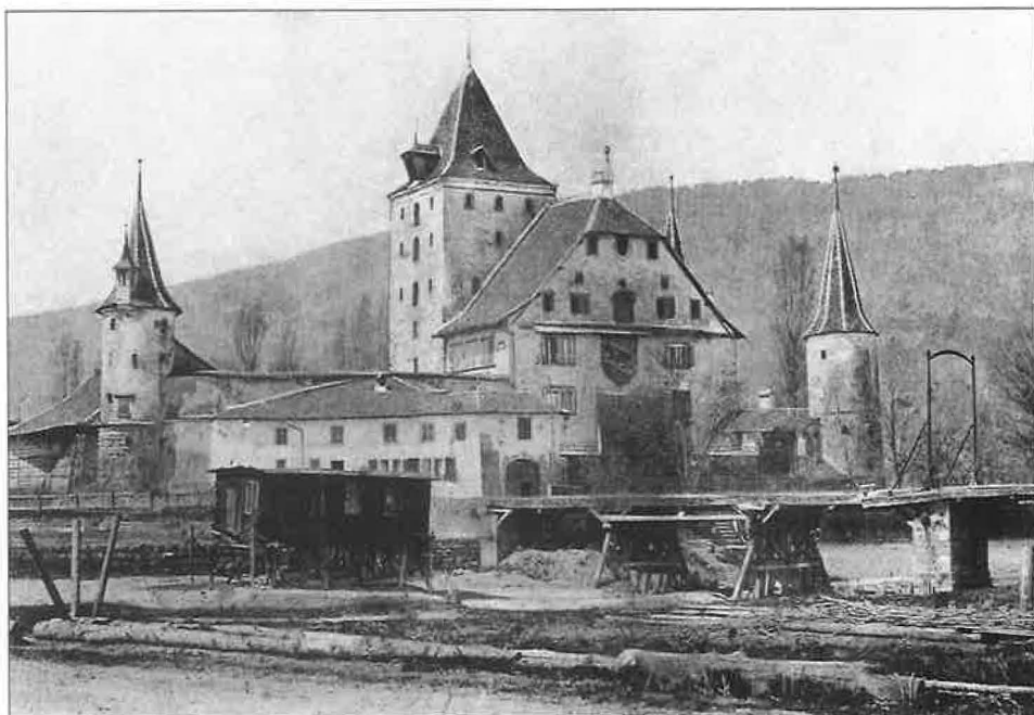
Abb. 33: Die Zugbrücke zu Beginn der Abbrucharbeiten (1877). Das Aufziehrad und die Aufzugsketten über den «Galgen» sind bereits demontiert. Im ehemaligen Flussbett der Grossen Zihl steht eine Baubaracke. Die Absenkung des Wasserspiegels (ca. 2,2–2,4 m) und die Verschmälerung des Flusslaufes sind erkennbar.
