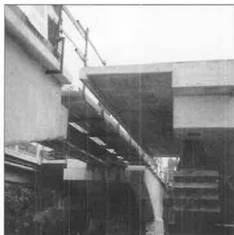
Abb. 54: Foto 1995. Östlicher Brückenteil (Richtung Biel) nach Abtrennung des Mittelteils. Im Vordergrund Fangnetz. Links im Bild ein Teil der 1980 erstellten separaten Radfahrerbrücke.
