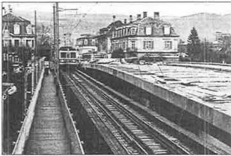
Abb. 72: Strassenbrücke 1978/79 ist im Rohbau erstellt. Links altes Trasse der BTI-Bahn; weiter links Notbrücke für die Fussgänger. Im Hintergrund links Restaurant Du Pont.
