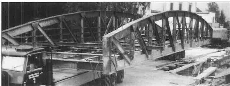
Abb. 50: Die alte Eisenbrücke wird angehoben, die neue Brückenhälfte darunter geschoben (erstmal in der Schweiz). Anschliessend wird die alte Brücke auf Lastwagen verladen und über die neue Brücke hinweg auf der Dr.-Schneider-Strasse zum Abbruch abgestellt.
