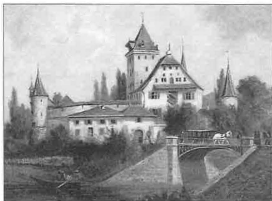
Abb. 35: Neue Schlossbrücke von 1877, eiserne Bogenfachwerkbrücke. Breite zwischen Eisengeländern 9 m. Davon entfallen 7,2 m auf die Fahrbahn und 1,8 m auf einen flussaufwärts angeordneten Fussweg (Trottoir). 7 Bogenfachwerkträger aus Schweisseisen im gegenseitigen Abstand von 1,4 m tragen die Zorseisen worauf das Schotterbett der Strasse ruhte. Die Lichtweite zwischen den Brücken-Widerlagern beträgt nur noch 12 Meter.
