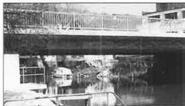
Abb. 50: Die alte Eisenbrücke wird angehoben, die neue Brückenhälfte darunter geschoben (erstmal in der Schweiz). Anschliessend wird die alte Brücke auf Lastwagen verladen und über die neue Brücke hinweg auf der Dr.-Schneider-Strasse zum Abbruch abgestellt.
