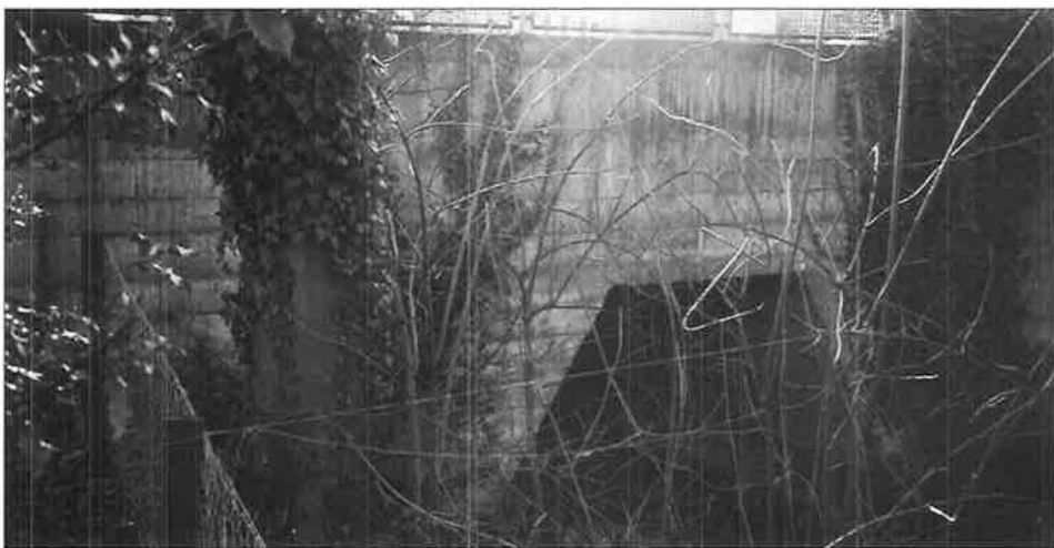
Abb. 43: Foto 2002. Beginn der Überdeckung der 1931/32 begradigten und kanalisierten Madretsch-Schüss ab Liegenschaft Gribi. Die «Betonbrücke» ersetzt die 1880 tiefer gelegte Schüssbrücke.
