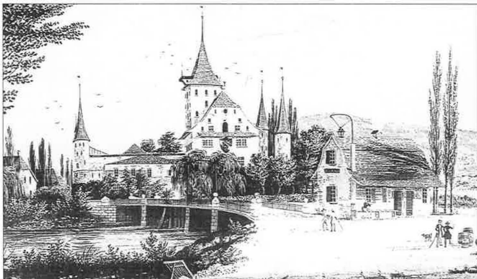
Abb.15: Zugbrücke nach Abbruch des Radhauses, mit neuer Ufermauer Seite Schloss und Reduktion der Anzahl Pfeiler von fünf auf vier, wovon einer (der zweite von Westen) nun aus Holz. Verkürzung der Brücke auf ca. 43 m. Die neue Aufziehvorrichtung mit «Galgen» zwischen zweitem und drittem Pfeiler von links sind schwach erkennbar, aufziehbarer Brückenteil zwischen drittem und viertem Pfeiler. Rechts im Bilde das Zollhaus (Wächterhaus) mit Gaslampe, das beim Bau der neuen Strasse nach Biel 1846 abgebrochen wurde. Das Bild ist in die Zeit zwischen 1826 und 1846 zu datieren.
