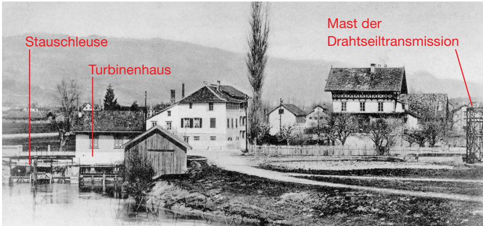
Abb. 5: Im linken Bildteil das Turbinenhaus mit zwei geschlossenen Fensterläden, darunter Einrichtungen der Turbinenanlage, links davon Stauschleuse, rechts ein Schuppen, im Hintergrund Mitte Gebäude Gribi, rechts Hotel Gurnigel. Postkarte ist datiert vom 13.09.1901; das 1899 abgebrannte Sägereigebäude ist deshalb nicht mehr sichtbar. Im rechten Bildrand erster Mast mit Seilscheibe der Drahtseiltransmission ab der Säge zur Brückenbau Werkstätte in den Aalmatten.
