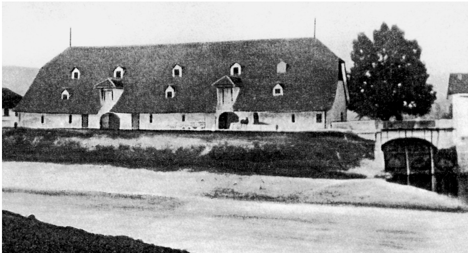
Abb. 3: Ehemaliges Salzhaus, abgebrochen 1899, rechts davon die Stauschleuse mit drei «hölzernen Feldern» in der Madretsch-Schuss, dahinter das Gewölbe von sieben Meter Spannweite der steinernen Bogenbrücke über die Madretsch-Schuss nach erfolgter Tieferlegung 1880. Am rechten Bildrand nördlicher Teil des Turbinenhauses. Im Vordergrund abgesenktes Zihlbett. Photo nach 1880 jedoch vor 1899 (Abbruch Salzhaus).
