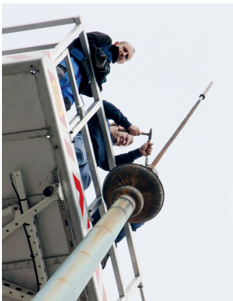
Hebebühne in vierzig Meter Höhe, «Plattform» zur Demontage der Wetterfahne und des Knaufs.
