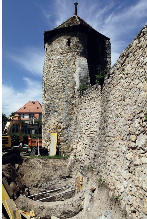
Abb. 1: Nidau, Ziegelhüttenturm. Unterfangung der anschliessenden Stadtmauer während der Sanierungsarbeiten 2017. Foto P. Zaugg, ADB.
