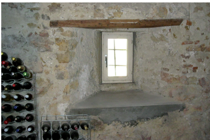
Abb. 21: Nidau, Schulgasse 15. Erhaltene Stadtmauer im Bereich der Südfassade der Liegenschaft mit einem Schartenfenster, einer vermutlich später vergrösserten Schiesscharte der mittelalterlichen Wehrmauer. Foto M. Schmitz, Nidau.
