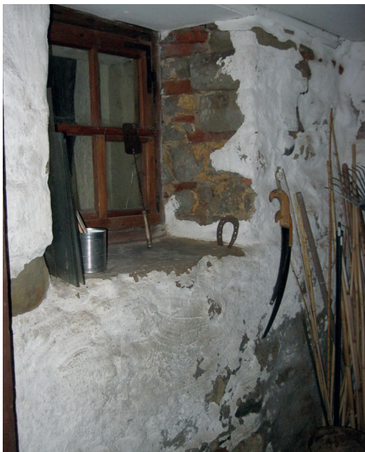
Abb. 20: Nidau, Schulgasse 7. Erhaltene Stadtmauer im Bereich der Südfassade der Liegenschaft mit einem später eingebrochenen Fenster. Vielleicht wurde wie in Schulgasse 15 eine mittelalterliche Schiesscharte erweitert. Foto M. Schmitz, Nidau.
