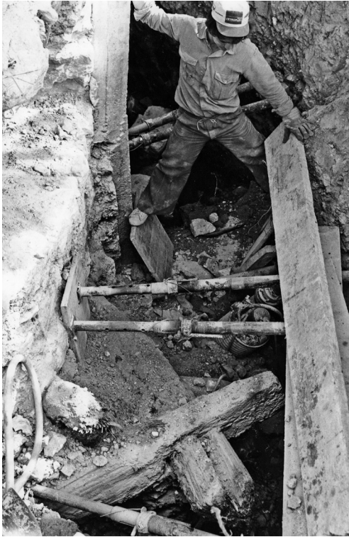
Abb. 11: Nidau, Ziegelhüttenturm. Bohrarbeiten unter dem Turmfundament für die Presspfähle der neuen Gründung 1980. Foto Ingenieurbüro Oechslin, Cremona, Weber AG. Archiv ADB.
