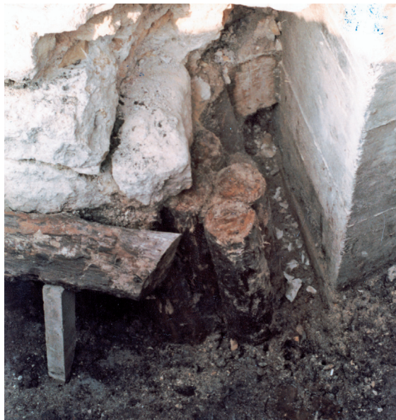
Abb. 10 Nidau, Ziegelhüttenturm. Bei den Fundamentierungsarbeiten 1980 freigelegte mittelalterliche Gründung des Turms mit senkrecht eingeschlagenen Tannenpfählen und darüber einem Rahmen aus Eichenbalken. Ingenieurbüro Oechslin, Cremona, Weber AG. Archiv ADB.
