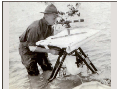
Kippregel/Messtisch/Basislatte: Ab ca. 1900
