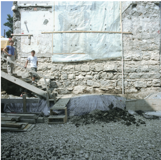
Abb. 16 Nidau, Hauptstrasse 73a. Freigelegtes Kalksteinfundament auf der Ostseite des mittelalterlichen Wohnturms an der südöstlichen Ecke der Stadtbefestigung während der Sanierung 1989. Foto ADB.
