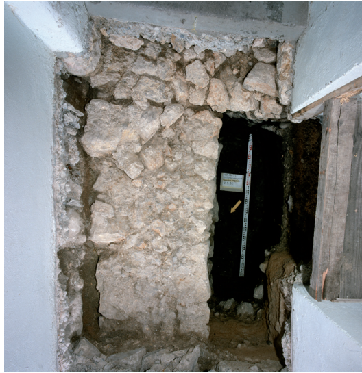
Abb. 19: Nidau, Schulgasse 17. An das Stadtmauerfundament im Hintergrund ist das jüngere mittelalterliche Fundament einer Brandmauer der Parzellenbebauung angefügt. Blick von oben während der bauarchäologischen Grabungen 1991. Foto ADB.
