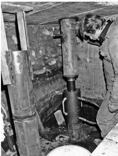
Abb. 8: Nidau, Ziegelhüttenturm. Bohrarbeiten unter dem Turmfundament für die Presspfähle der neuen Gründung 1980. Foto Ingenieurbüro Oechslin, Cremona, Weber AG. Archiv ADB.
