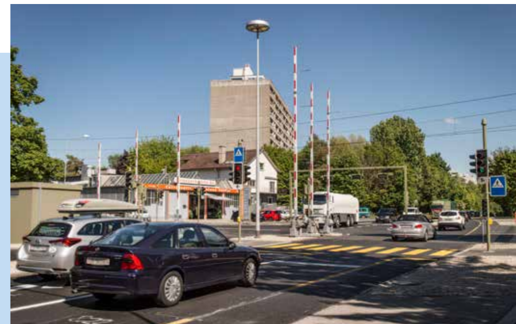
La route de Berne restera fortement encombrée jusqu'à la construction d'un contournement ouest.
