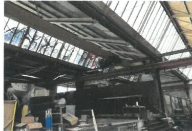
Detail Zustand Ausbau
