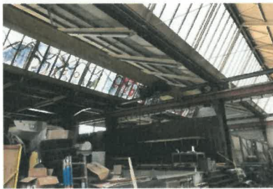
Detail Zustand Ausbau
