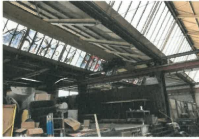
Detail Zustand Ausbau
